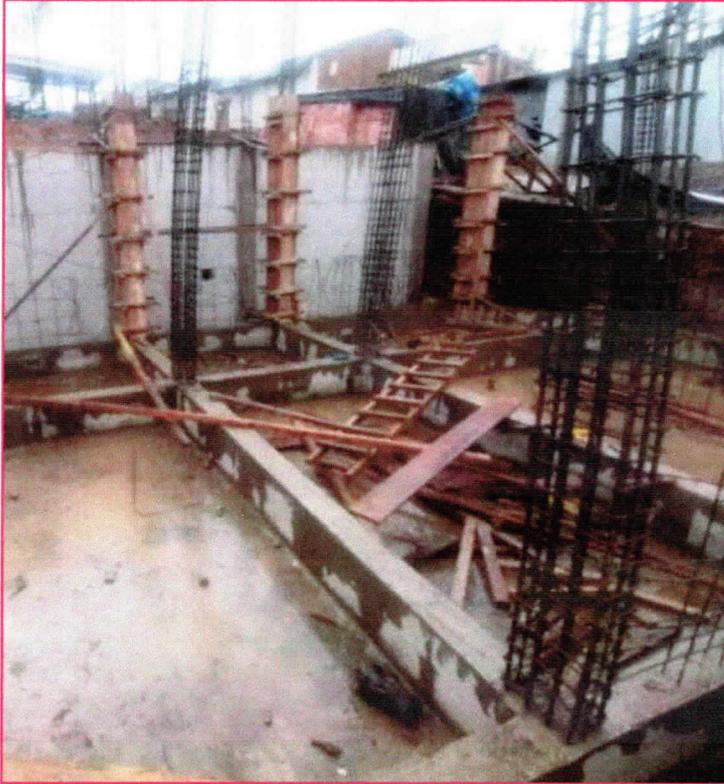
Se deja notar en la imagen que no se pueden realizar trabajos de relleno y compactación debido a la saturación excesiva del suelo producto de las constantes lluvias que se vienen presentando
