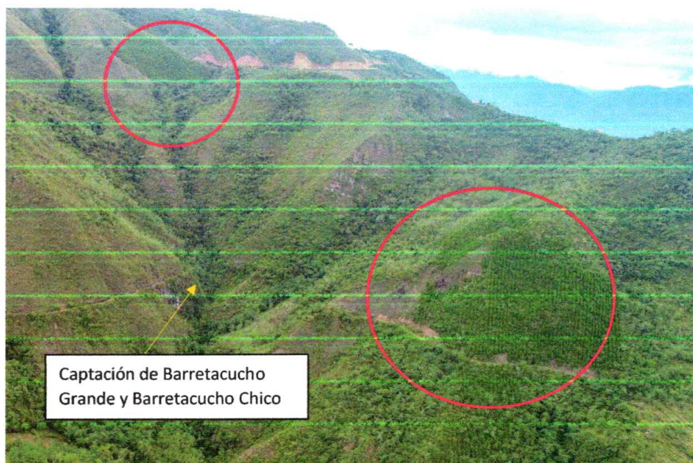
Figura 39. Siembra de pinos en zonas aledañas a la captación Barretacucho
