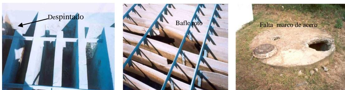
Las placas rotas causan cortocircuitos y espacios muertos, lo que produce la acumulación de lodo en esta parte de los canales (ver foto). En toda la unidad se observa que en las esquinas de los canales existen espacios muertos que hacen que el tiempo de retención real disminuya.
