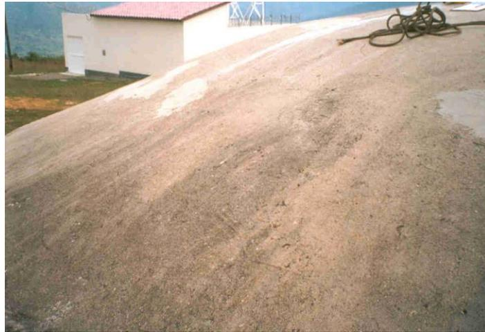
**Desgaste del concreto en la cara externa de la cúpula**
