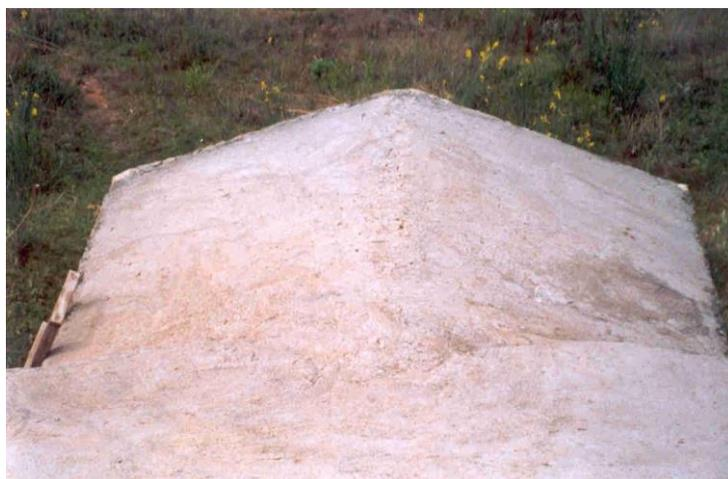
**Losa de techo sin recubrimiento expuesta a las lluvias**
