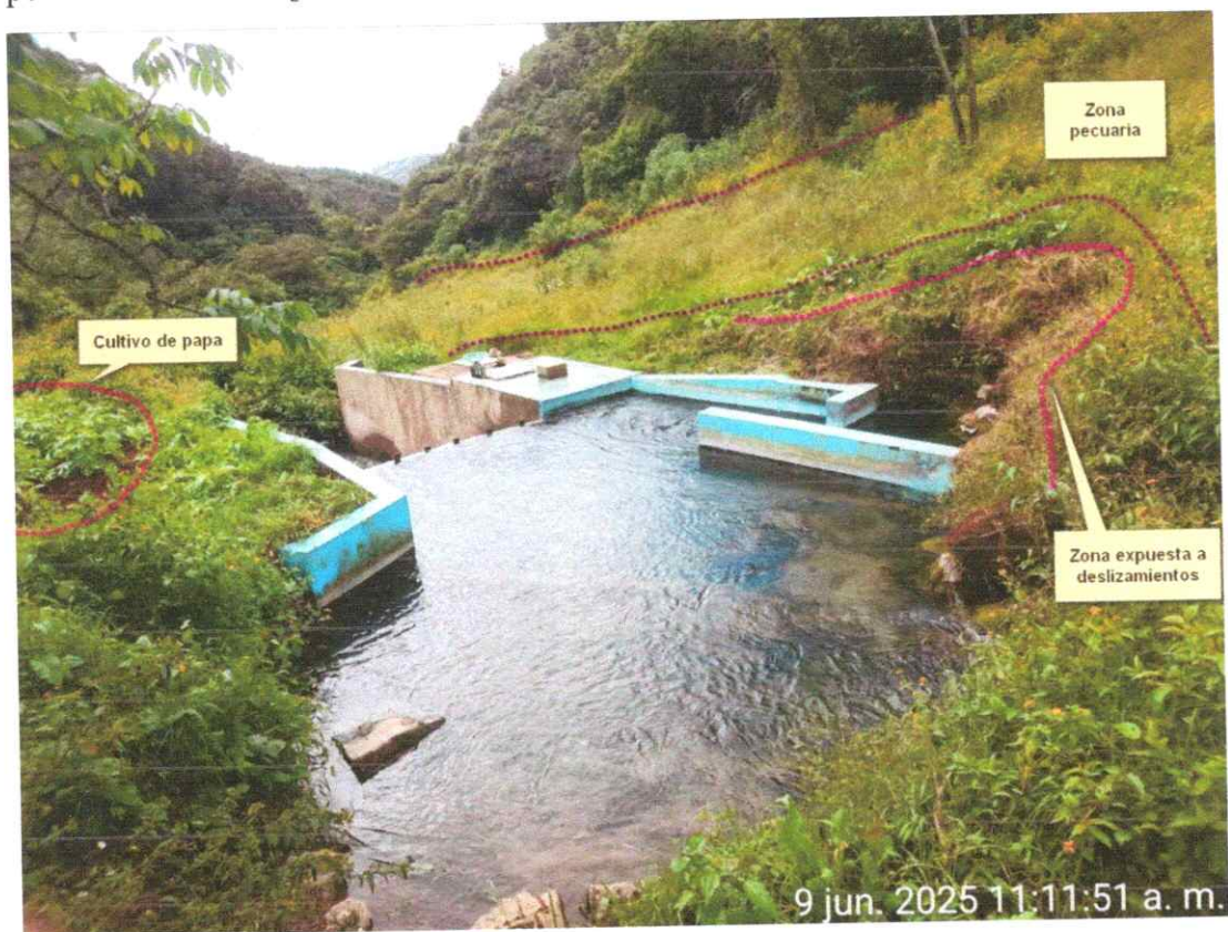
Foto 01: Fuente de agua 'Ganchi' expuesta a contaminación microbiológica y amenazas por lluvias intensas. [Junio/2025].
