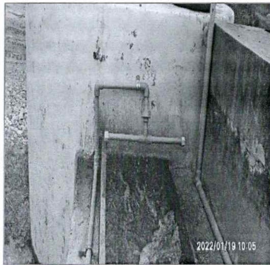
Dosificador Sulfato de Cobre
